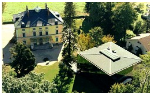
Figure 3: Le site du XRCE
